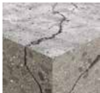
Repedéses beton
